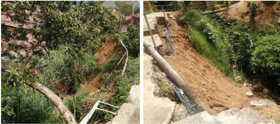
Ilustración 55 Registro fotográfico componente Suelo. Fuente: Elaboración propia – Recorridos auxiliares de campo
